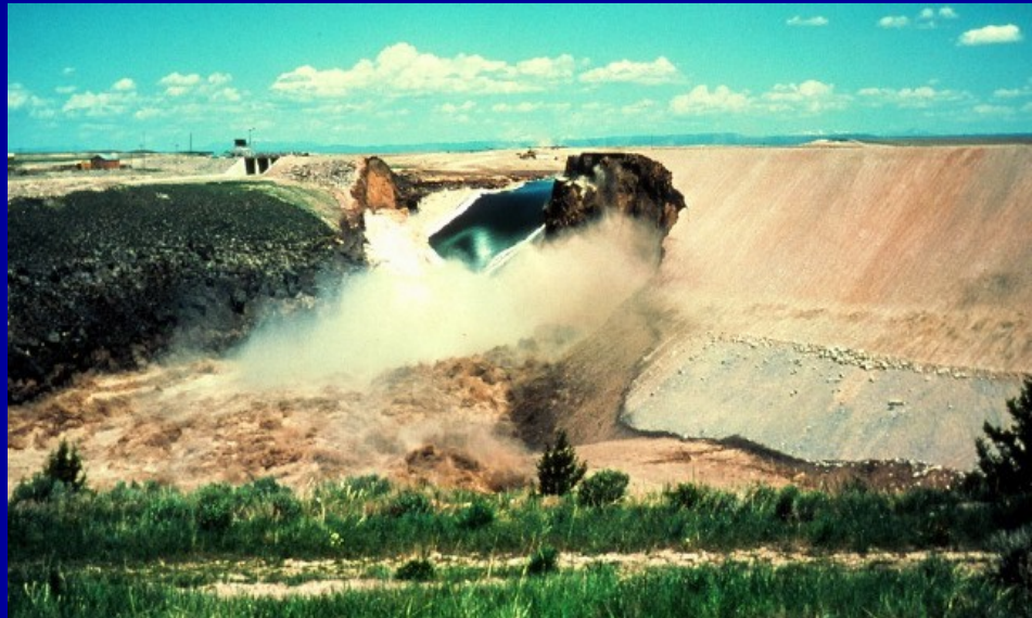
Erosão tubular (Barragem de Teton EUA, 1976)
